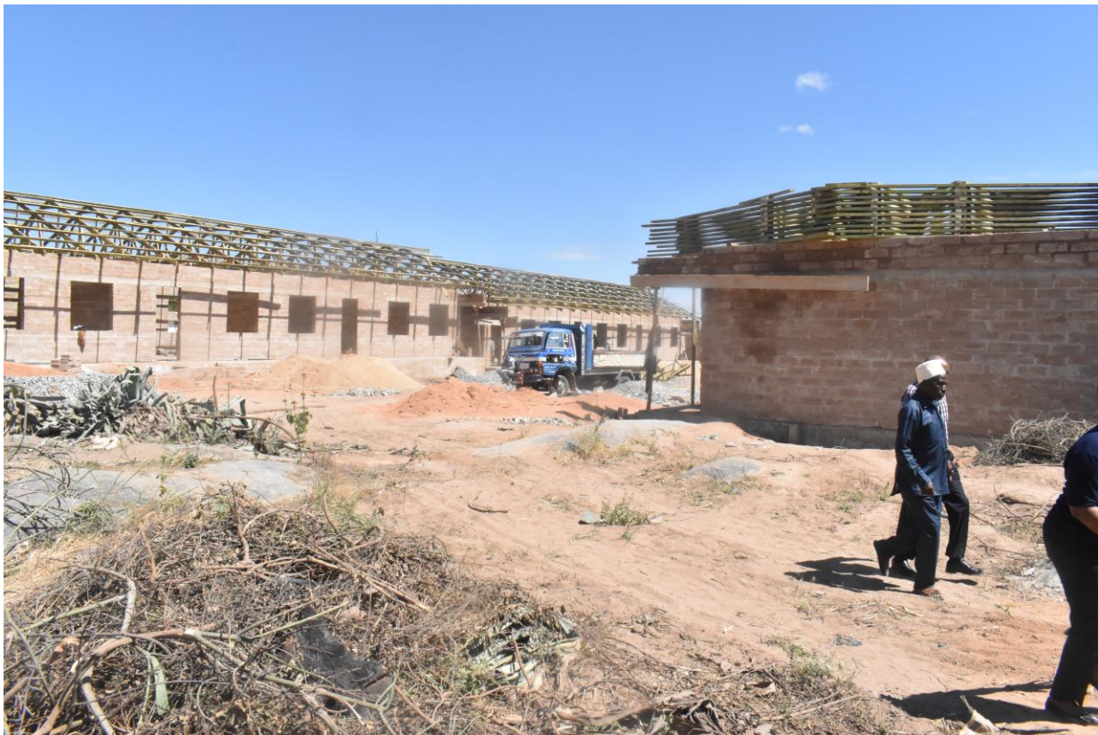
Ujenzi wa vyumba vya madarasa katika shule mpya ya Minga ukiwa katika hatua ya uwekaji kenchi.
