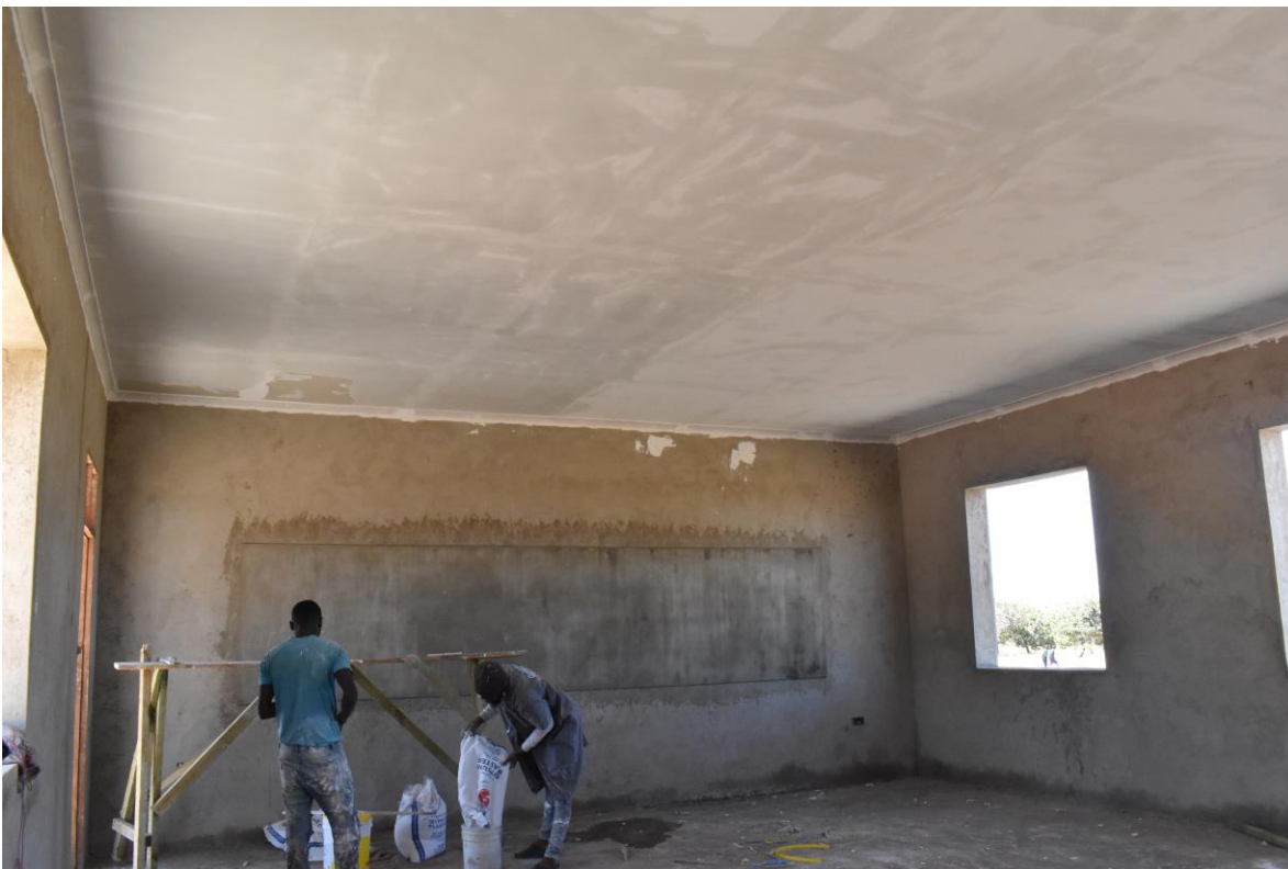
Taswira ya ndani ya jengo mojawapo la vyumba 03 vya madarasa katika shule ya Msingi Mwaja likiwa katika hatua ya uwekaji "gypsum board".
