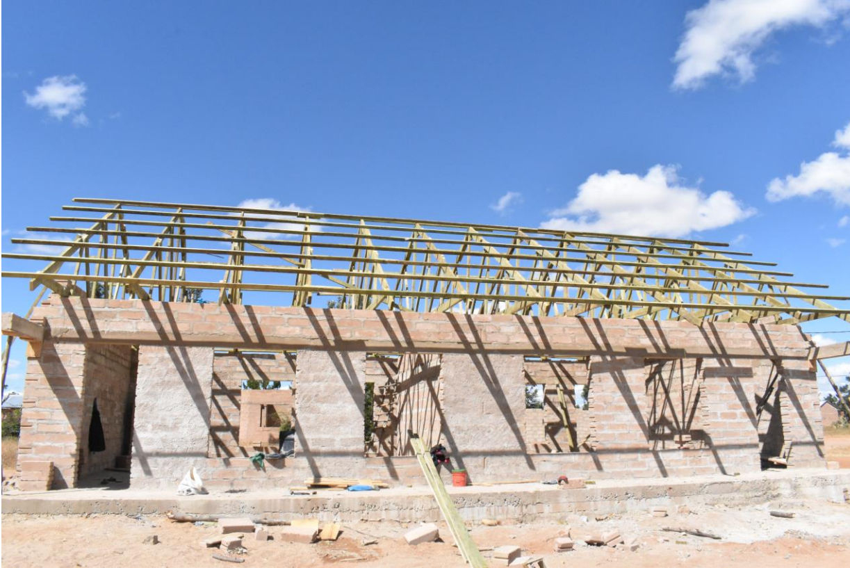
Ujenzi wa vyumba 02 vya madarasa shule ya awali ya mfano ya Manguanjuki, ukiwa katika hatua ya kenchi.
