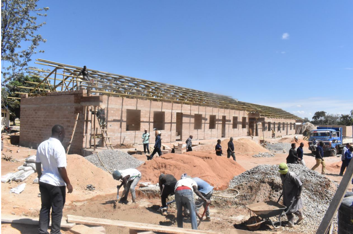
Mwonekano wa mbele wa madarasa katika shule mpya ya Minga ukiwa katika hatua ya kenchi.
