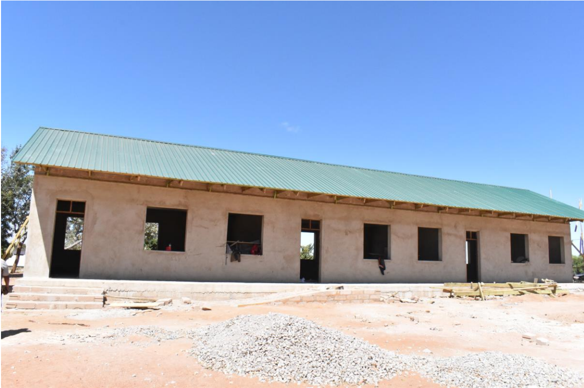
Mwenekano wa jengo la vyumba 03 vya madarasa kwa mbele, katika shule ya msingi Mwaja likiwa tayari limezekwa na kupigwa lipu.
