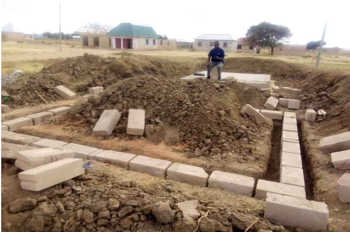
Ujenzi wa matundu vyoo matundu 04 ukiwa katika hatua ya ujenzi wa msingi
