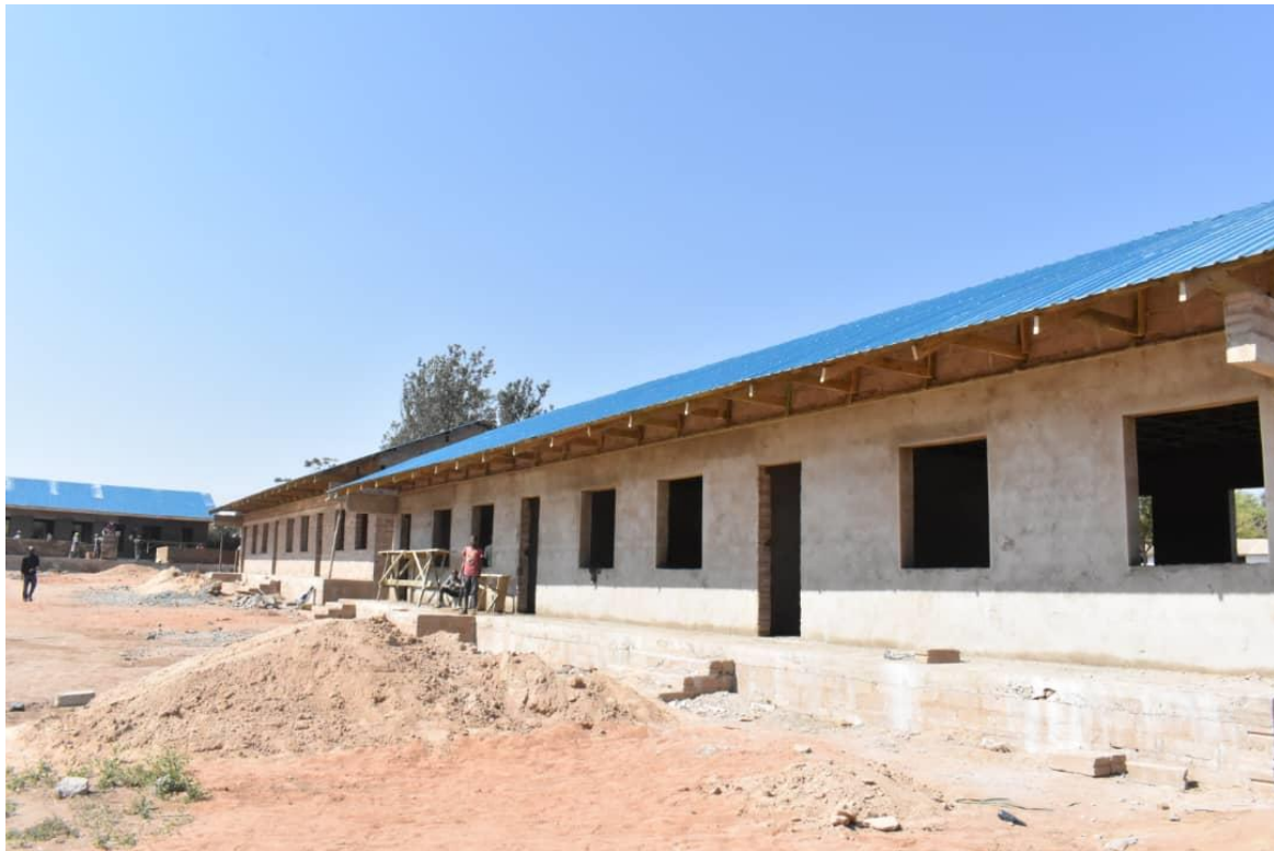
Ujenzi wa vyumba vya madarasa katika shule mpya ya Minga ukiwa katika hatua za ukamilishaji.
