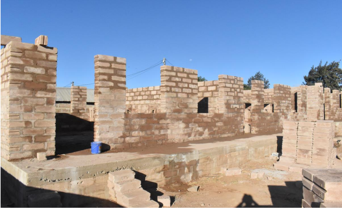
Ujenzi wa vyumba vya madarasa katika shule Mpya ya Nyerere ukiwa unaendelea katika hatua ya boma
