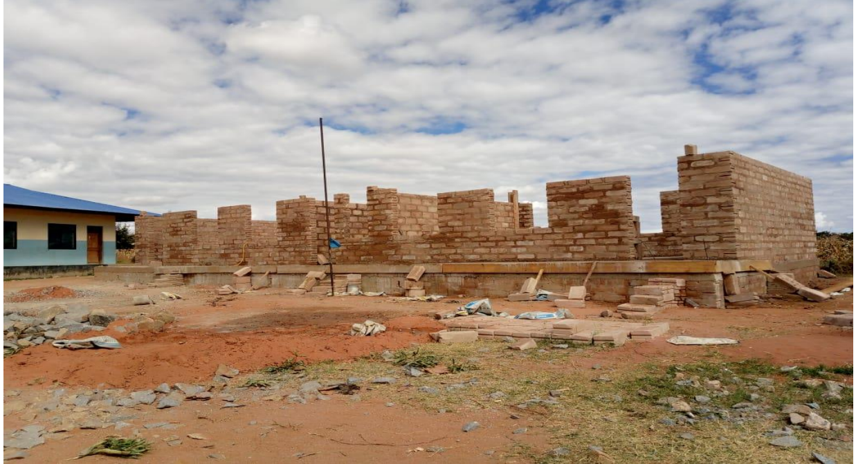
Ujenzi wa vyumba 02 vya madarasa shule ya Msingi Mnun'guna ukiwa katika hatua ya boma
