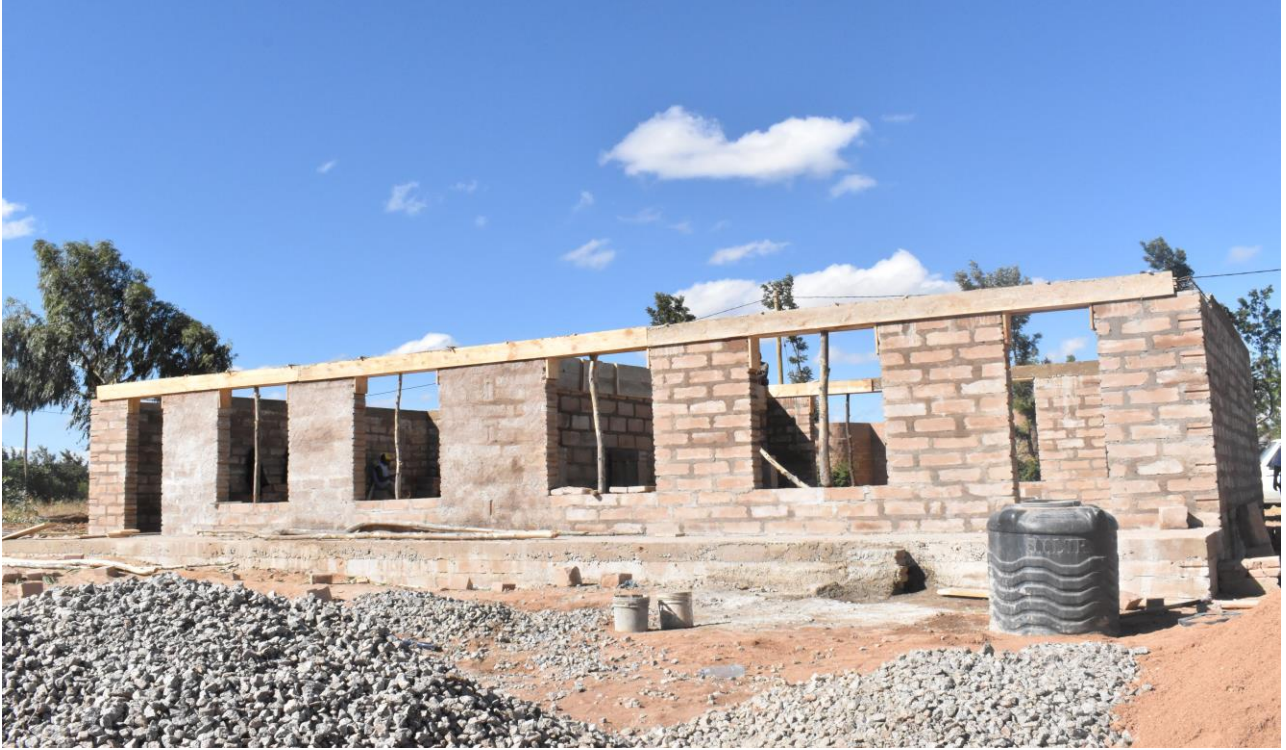
Ujenzi wa vyumba 02 vya madarasa shule ya awali ya mfano ya Manguanjuki, ukiwa katika hatua ya lenta
