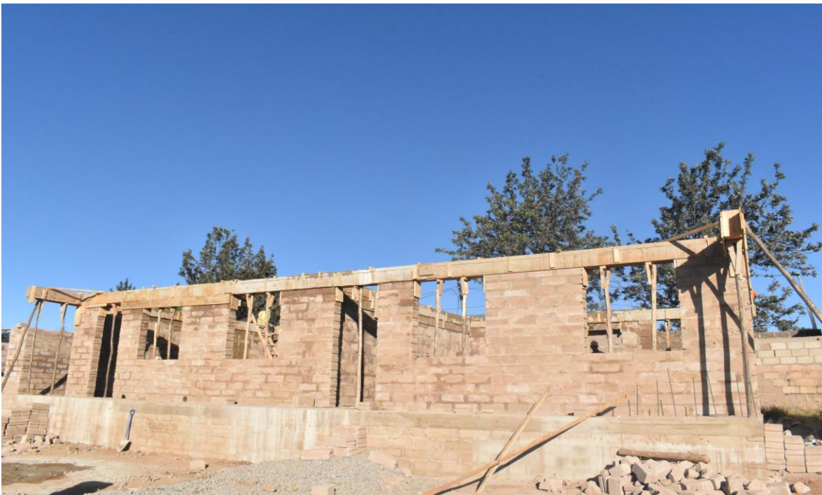
Mwonekano wa baadhi ya vyumba vya madarasa vikiwa katika hatua ya lenta. Jumla ya vyumba 08 vya madarasa viko katika hatua ya lenta
