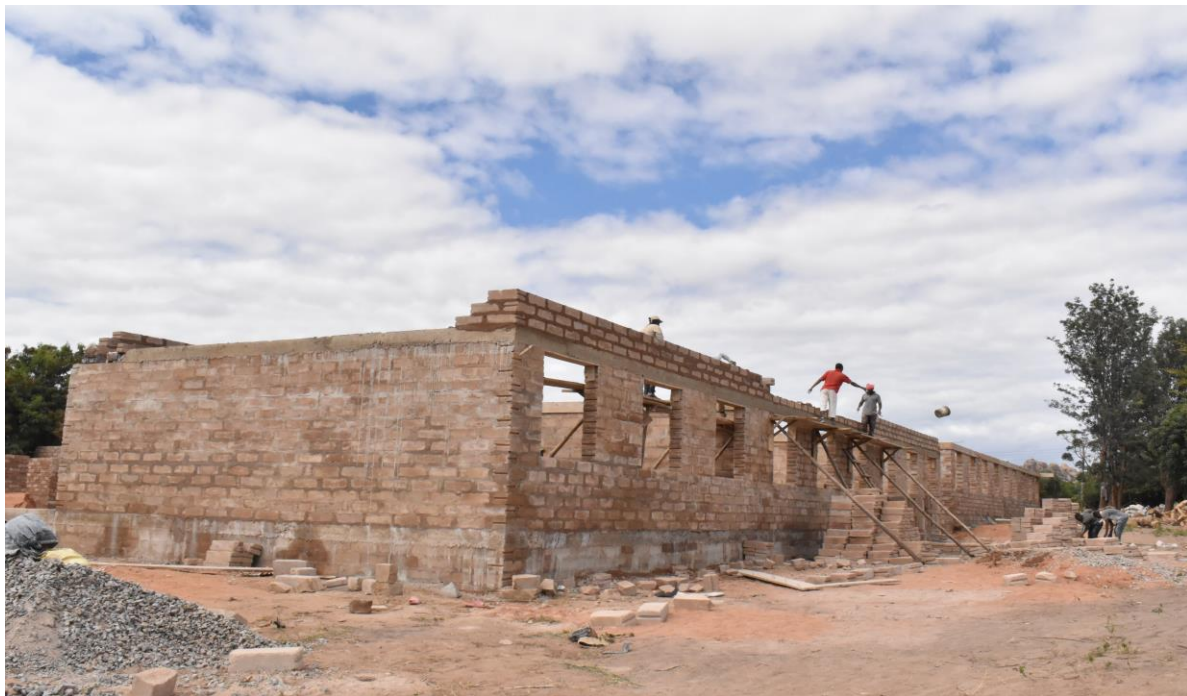
Ujenzi wa vyumba vya madarasa katika shule mpya ya Minga ukiwa katika hatua ya Hanamu
