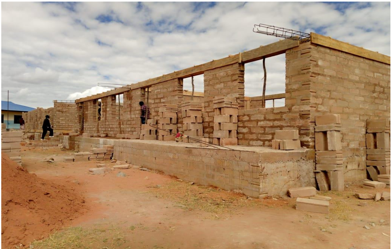
Mwonekano wa sura ya mbele ya vyumba 02 vya madarasa shule ya Msingi Mnung'una vikiwa katika hatua ya lenta
