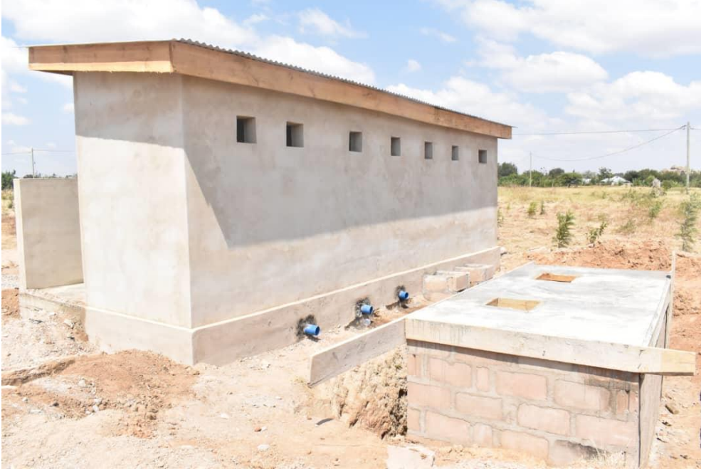
Ujenzi wa matundu 06 ya vyoo shule ya msingi Mwembemoja ukiendelea na hatua ya ukamilishaji
