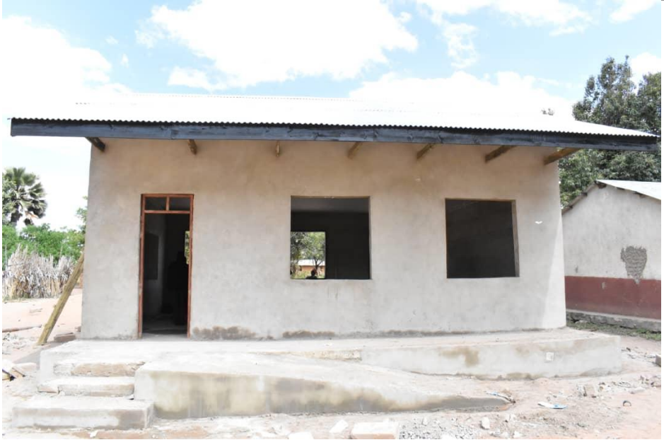
Ujenzi wa chumba 01 cha darasa shule ya msingi Mtamaa ukiwa katika hatua ya mbalimbali za ukamilishaji.
