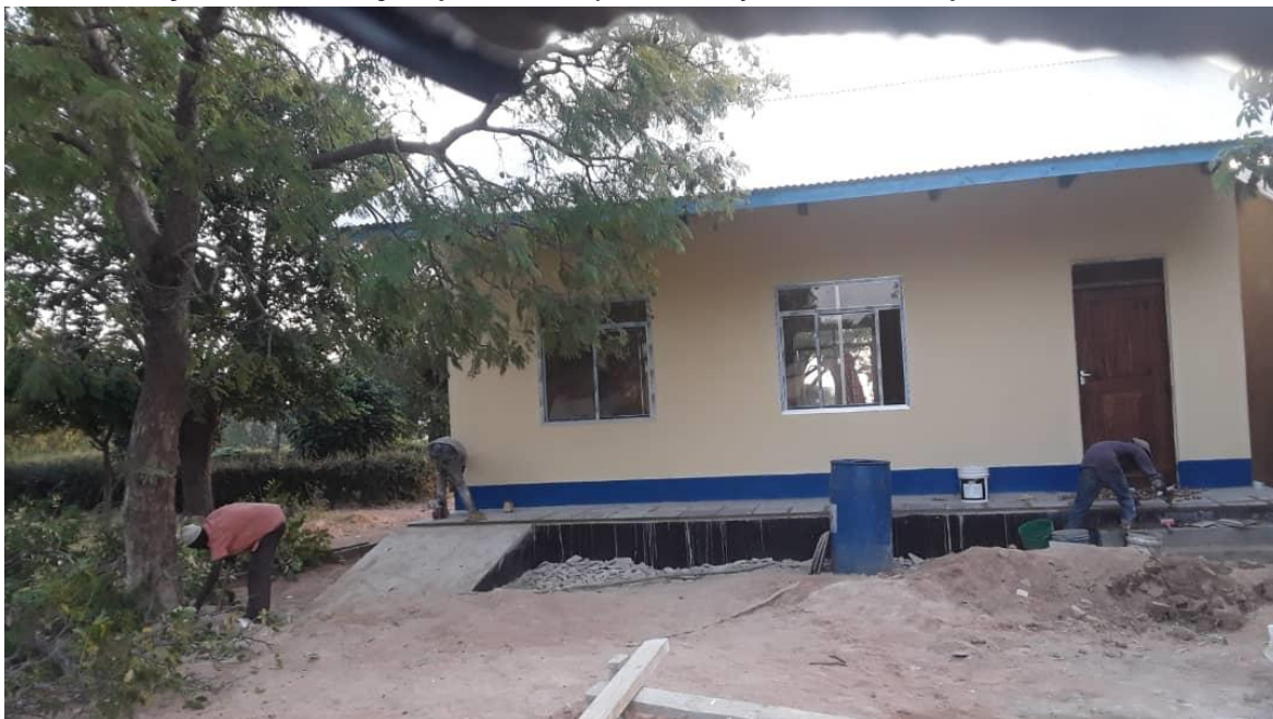
Ujenzi wa chumba 01 cha darasa shule ya msingi Kisaki ukiwa katika hatua ya ukamilishaji.
