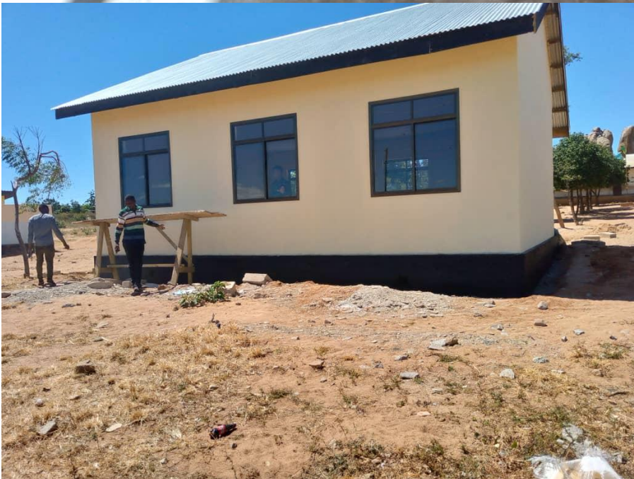
Ujenzi wa chumba 01 cha darasa shule ya msingi Kimpungua ukiwa umekamilika.
