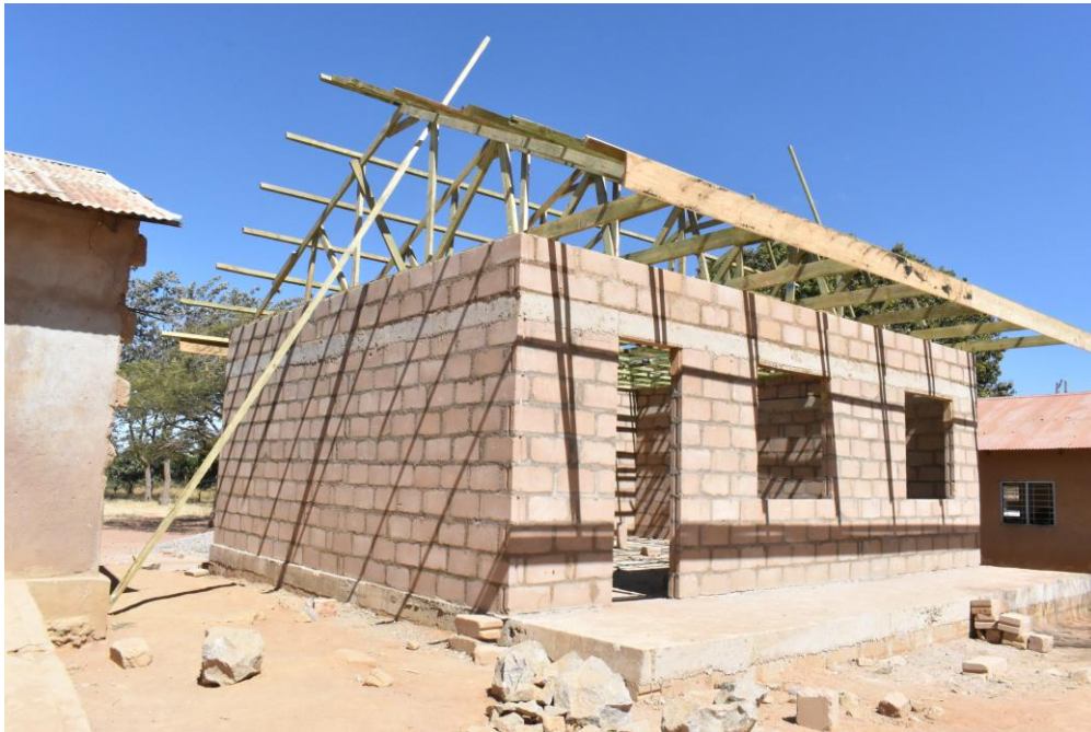
Ujenzi wa chumba 01 cha darasa shule ya msingi Kindai ukiwa katika hatua ya kuweka kenchi.
