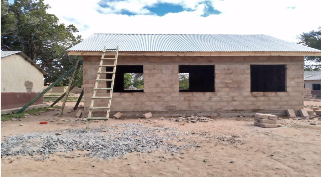
Ujenzi wa chumba 01 cha darasa shule ya msingi Mtamaa ukiwa katika hatua ya mbalimbali za ukamilishaji (upauaji)
