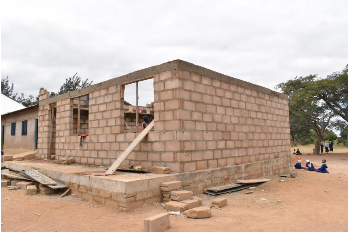
Ujenzi wa chumba 01 cha darasa shule ya msingi Kindai ukiwa katika hatua ya upauzi
