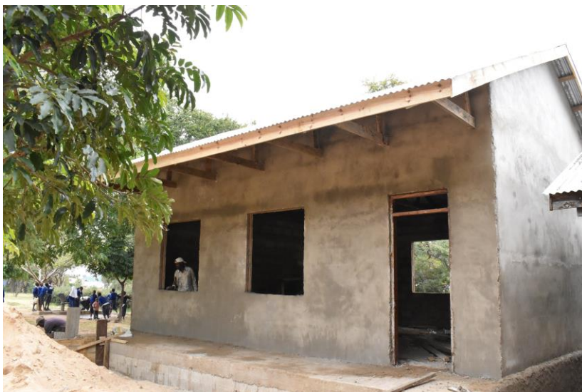
Ujenzi wa chumba 01 cha darasa shule ya msingi Kisasi ukiwa katika hatua ya upigaji lipu
