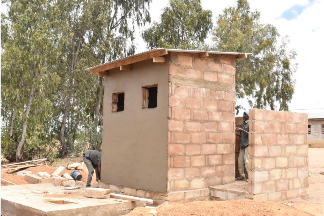
Ujenzi wa matundu 02 ya vyoo shule ya msingi Sundu ukiwa katika hatua ya ukamilishaji
