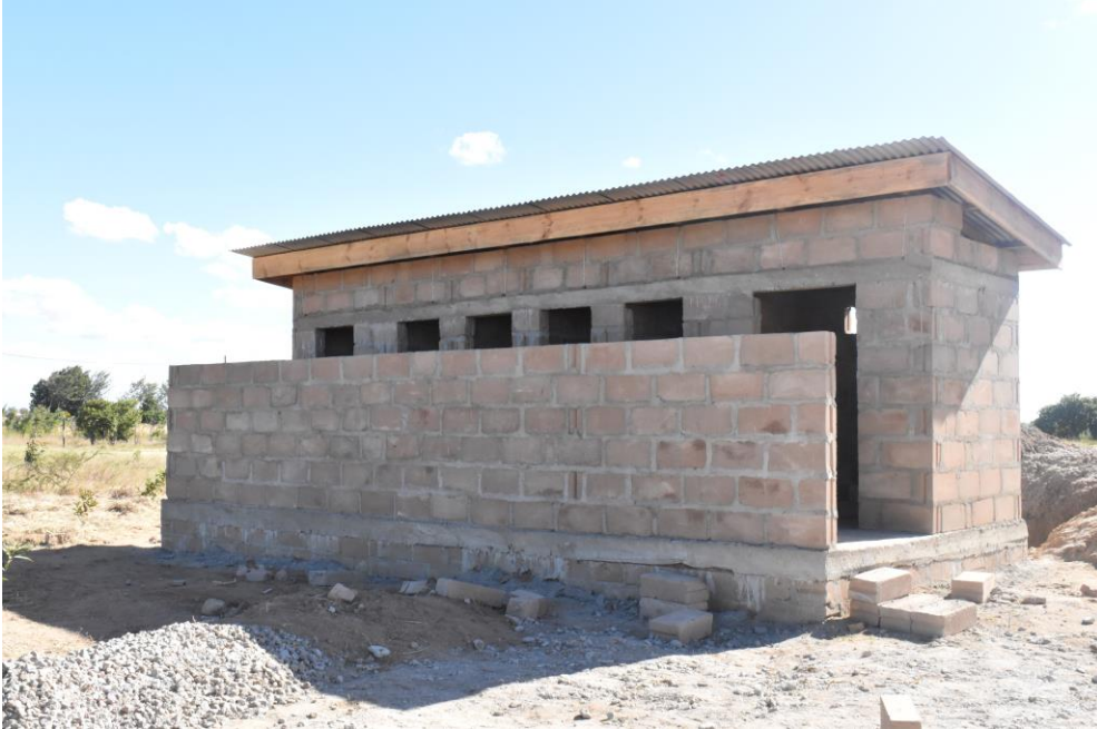
Ujenzi wa matundu 06 ya vyoo shule ya msingi Mwembemoja ukiendelea na hatu ya ukamilishaji
