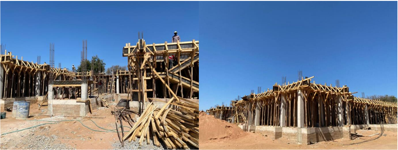
Jengo la utawala lipo katika hatua ya Kutengeneza boksi za sakafu ya kwanza (shuttering to first floor slab and beams).
