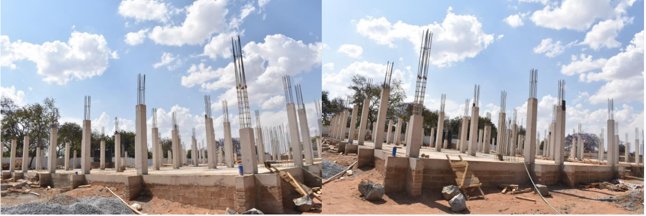
Jengo la utawala likiwa katika hatua ya nguzo za kutoka kwenye sakafu ya chini (ground floor) kwenda kwenye ghorofa ya kwanza (second floor).
