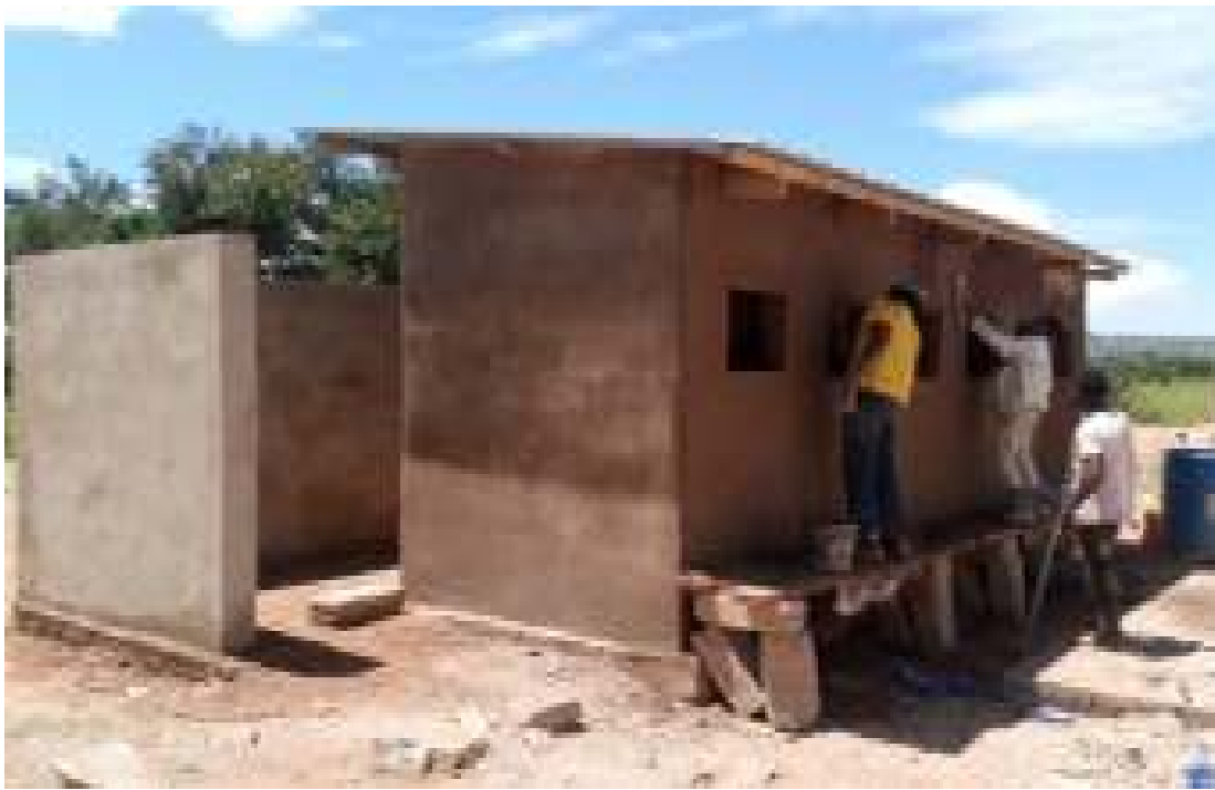
Ujenzi wa matundu 08 vya vyoo shule ya Manga (Sengasenga) ukiwa katika hatua ya kupiga ripu
