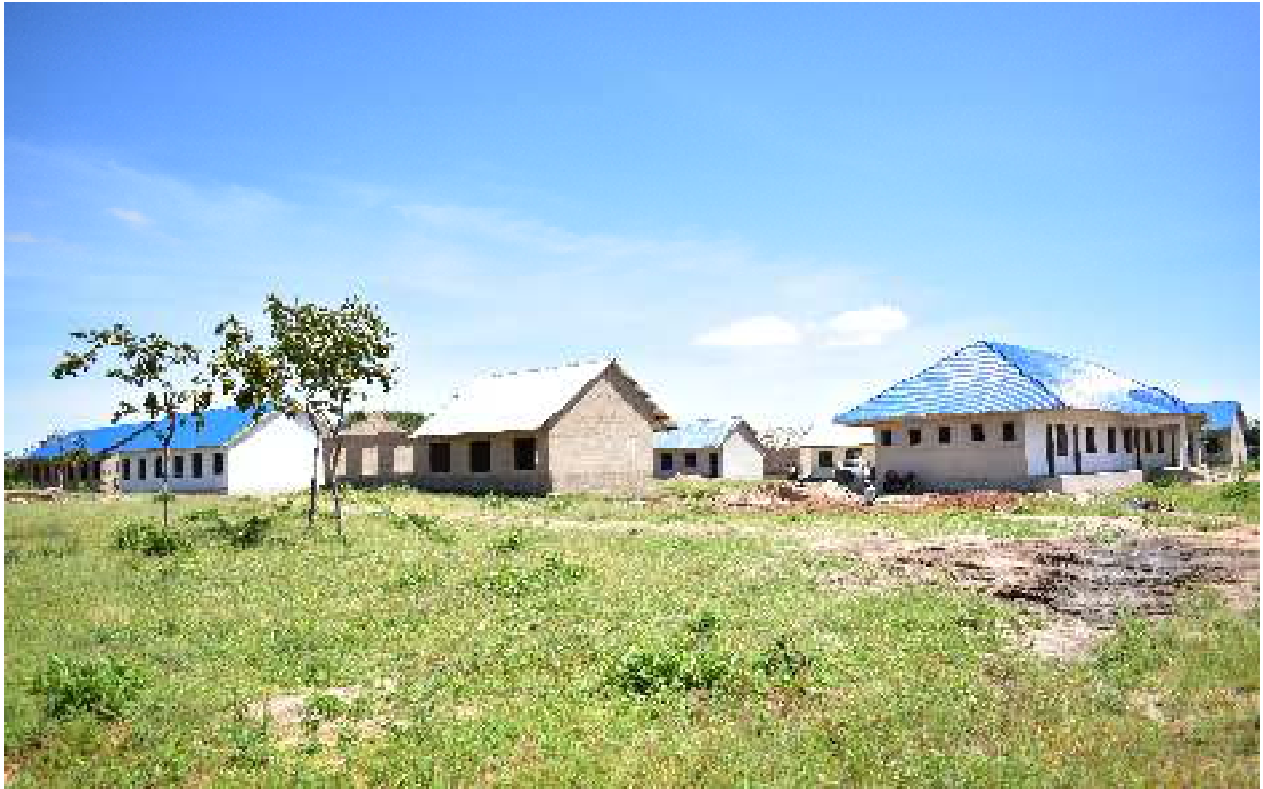
Sura ya majengo mbalimbali yanayoendelea kukamilishwa katika shule mpya ya Sekondari ya kata ya Uhamaka
