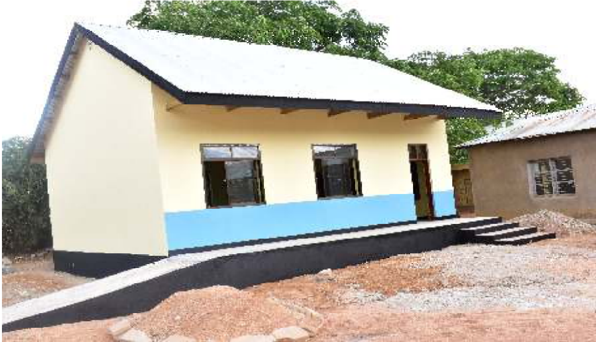
Chumba 01 cha darasa kikiwa kimekamilika katika shule ya sekondari Dr. Salmin Amour. Chumba hiki ni moja kati ya vyumba 34 vya shule za sekondari vilivyojengwa kwa fedha za UVIKO-19
