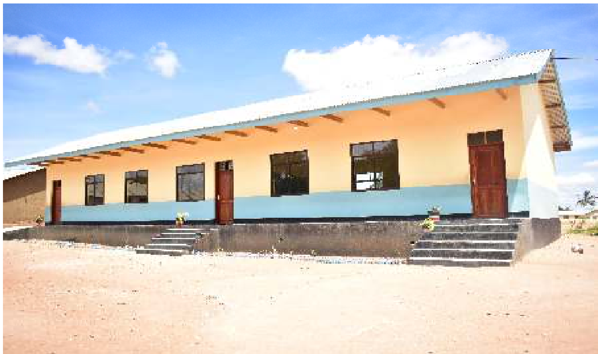
Vyumba 02 vya madarasa na Ofisi ya walimu katika shule ya msingi Ukombozi vilivyojengwa kwa fedha za LANES
