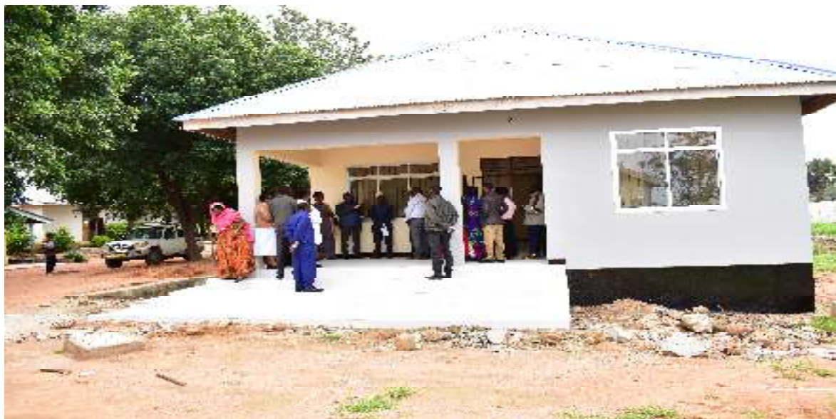
Kamati ya Fedha uongozi na utawala ilipotembelea jengo la mionzi katika kituo cha Afya Sokoine baada ya kukamilika.
