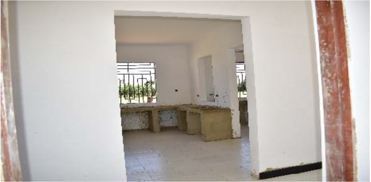
Mwonekano wa ndani wa Jengo la mabaara kituo cha afya Mandewa likiwa katika hatua mbalimbali za ukamilishaji. Majengo haya yanatarajiwa kukabidhiwa mwishoni mwa mwezi Mei, 2022
