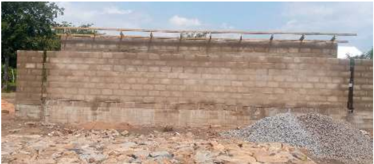
Ujenzi wa matundu 20 ya vyoo ukiwa katika hatua ya upauzi tarehe 14.03.2022
