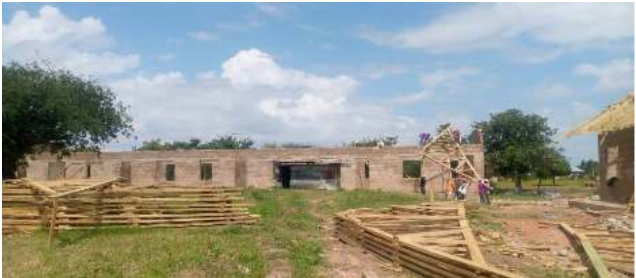
Zoezi la uwekaji kenchi katika vyumba 04 vya madarasa ukiendelea
