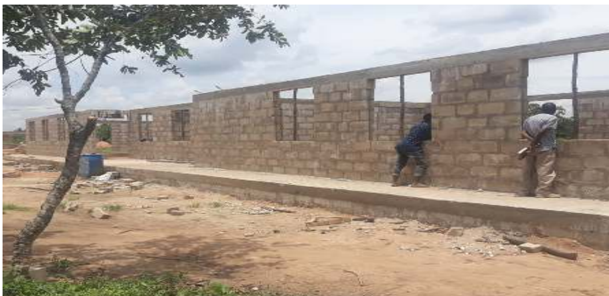
Ujenzi wa vyumba 03 vya maabara ukiwa katika hatua ya kufunga lenta tarehe 25.02.2022
