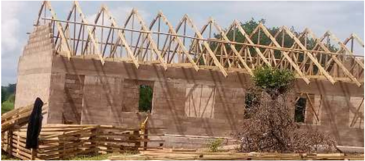
Ujenzi wa vyumba 02 vya madarasa ukiwa unaendelea katika hatua ya uezekaji
