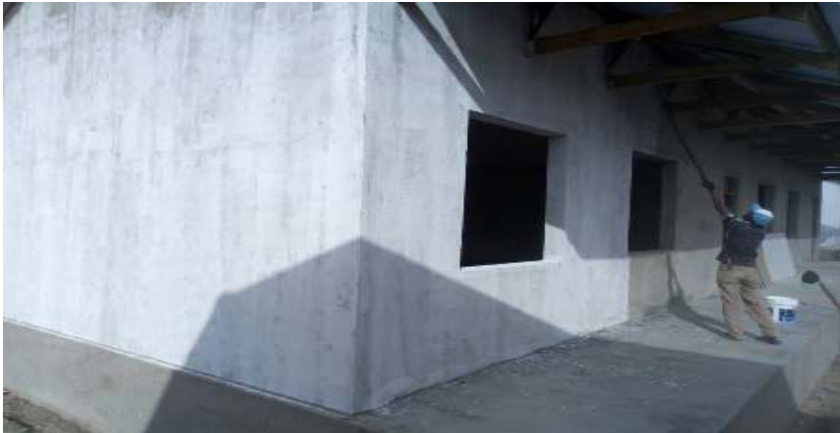
Mwonekano wa vyumba 02 vya madarasa vikipigwa rangi kwa nje.
