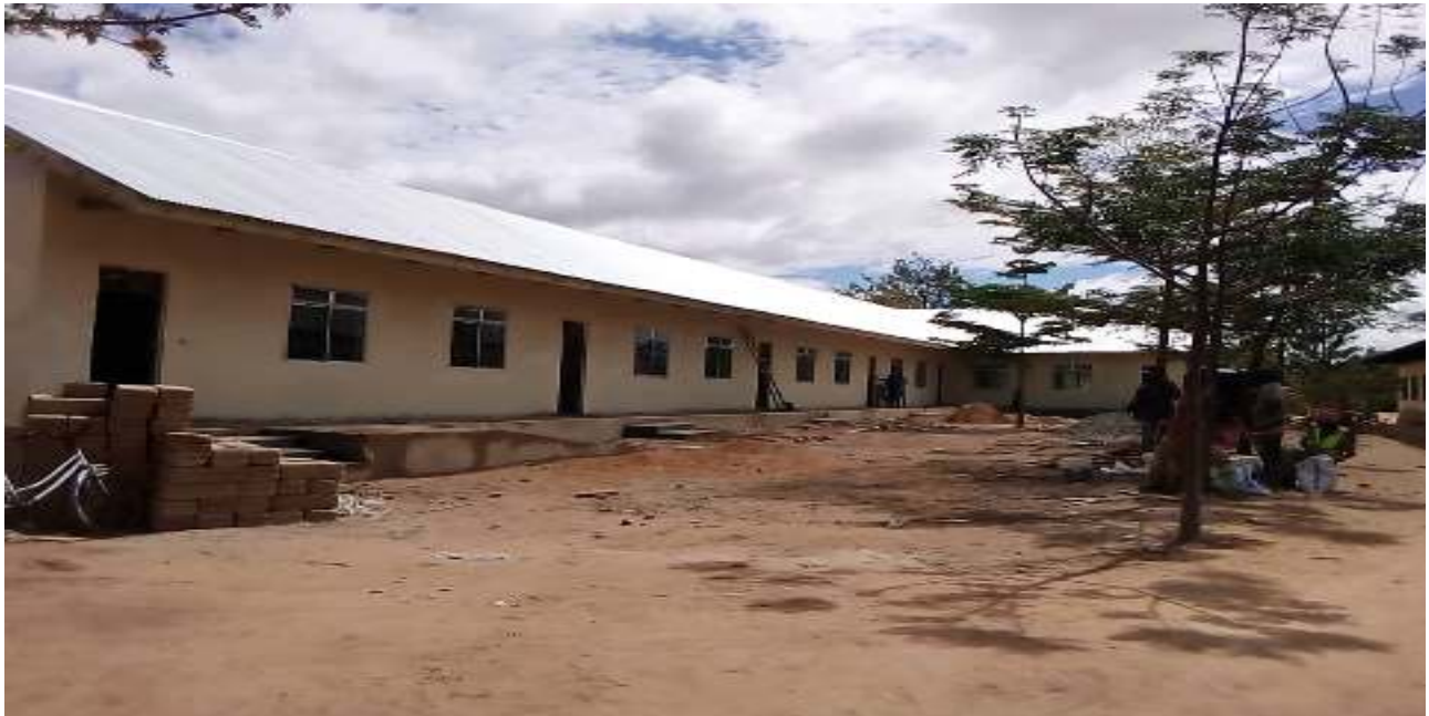
Mwonekano wa vyumba 06 vya madarasa kwa mbele
