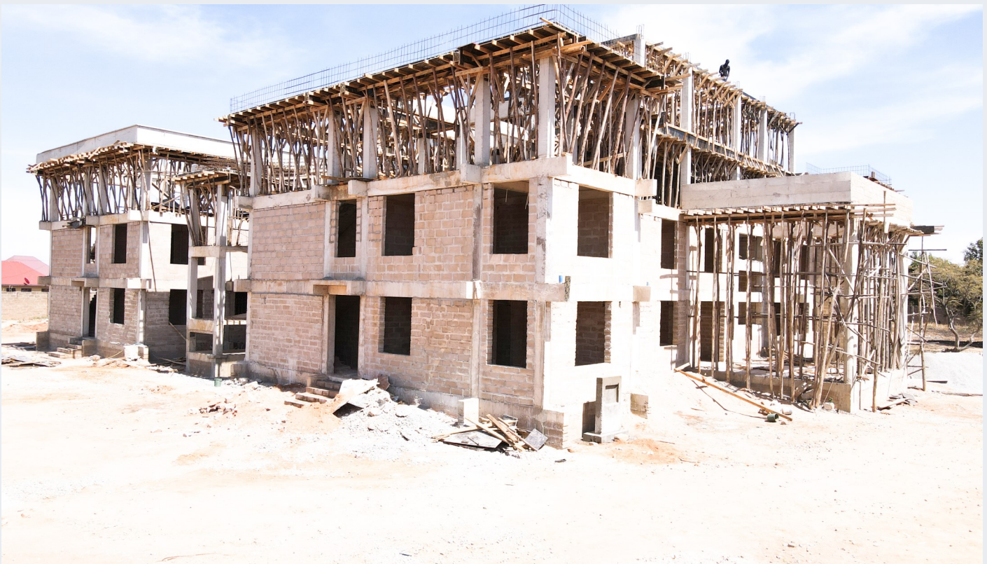
Jengo la Utawala la Manispaa ya Singida ujenzi unaendelea.
