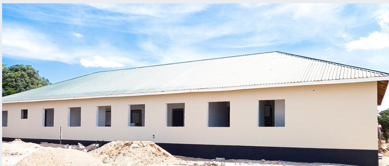
Jengo la Mama na Mtoto ujenzi ikiwa katika hatua ya ukamilishaji
