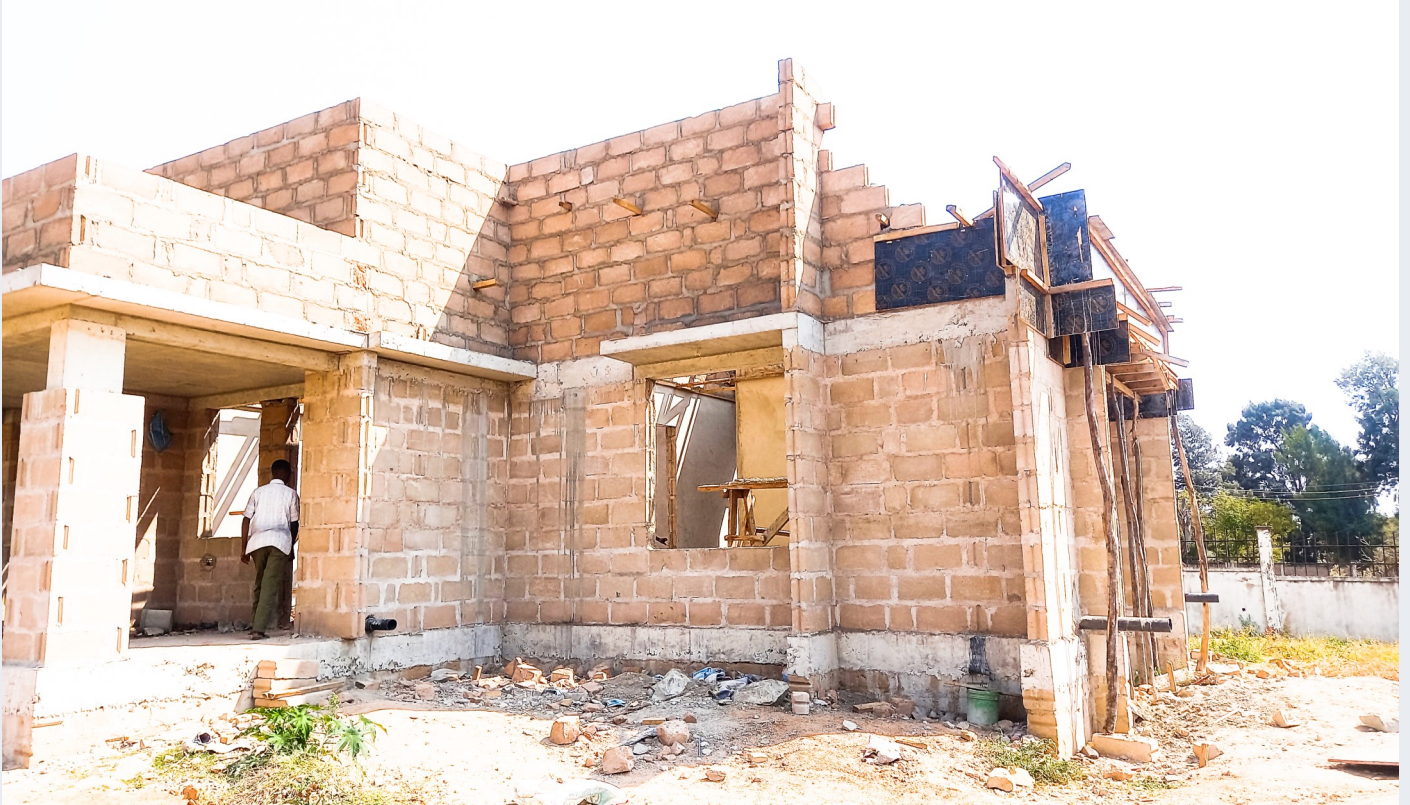
Muonekano wa Nyumba ya Mkurugenzi inaendelea na ujenzi katika hatua ya upauaji
